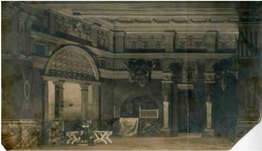
Pau Audouard (fotógrafo). Primer acto de la obra de teatro «Gal-la Placidia», de Ángel Guimerá, en el Teatro Novedades de Barcelona. Fotografía, gelatina de plata, 25 de mayo de 1909, deteriorada (Barcelona, Casa Lleó Morera. Paseo de Gracías 35, bajo). Fondo Adrià Gual. Centro de Documentación y Museo de les Artes Escèniques. Institut del Teatre (Barcelona))
